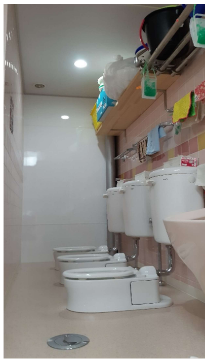
沐浴トイレ施工後
