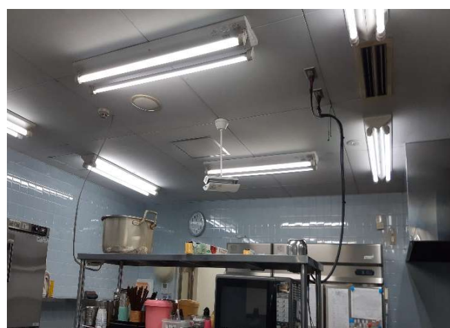
調理室施工後
